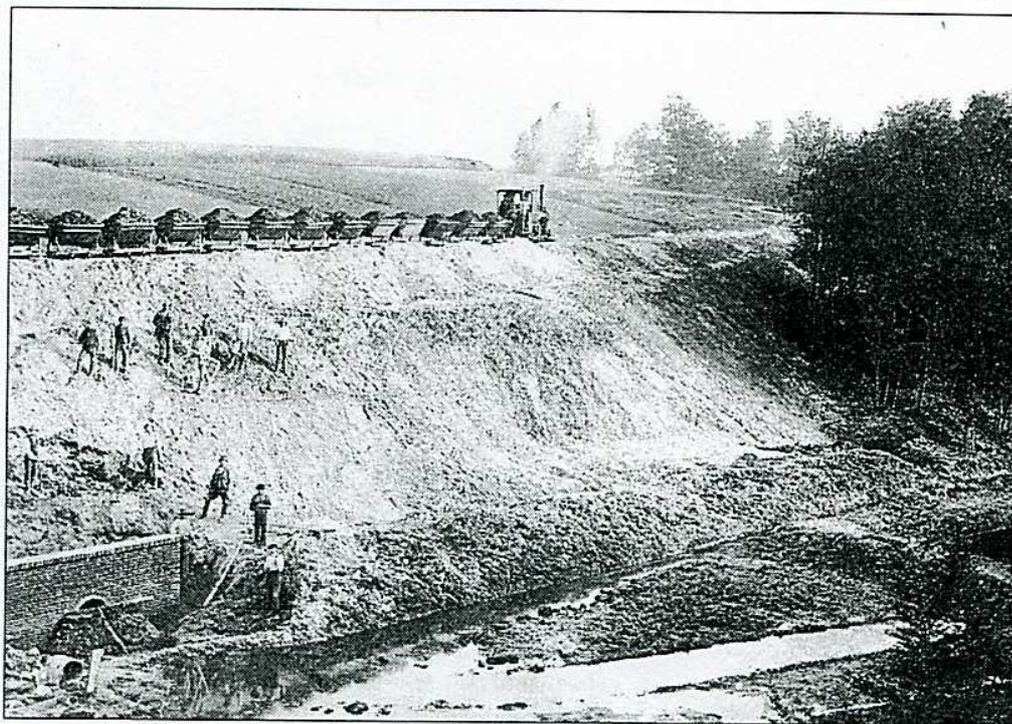
*Für die möglichst gleichmäßige Überwindung des Höhenunterschiedes von Bruchhausen-Vilsen auf den Geestrücken bis Heiligenberg musste im Vilsener Holz ein Damm aufgeschüttet werden. Man erleichterte sich die Arbeit, indem man das Material aus dem nachfolgenden Einschnitt verwendete. Für den Sandtransport wurde eigens eine Feldbahn gebaut.*
