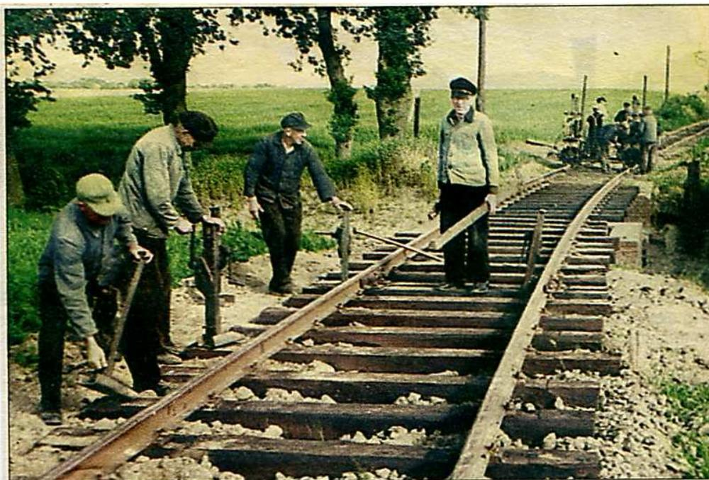
*Die Kleinbahner spuren die Strecke Bruchhausen-Vilsen-Syke von Meter- auf Normalspur um. Das fertig montierte Gleis wird zum Richten mit Winden angehoben und mit Schotter „gestopft“. Dieses Bild entstand 1965 an der „Bunten Brücke“ zwischen Uenzen und Süstedt.*
