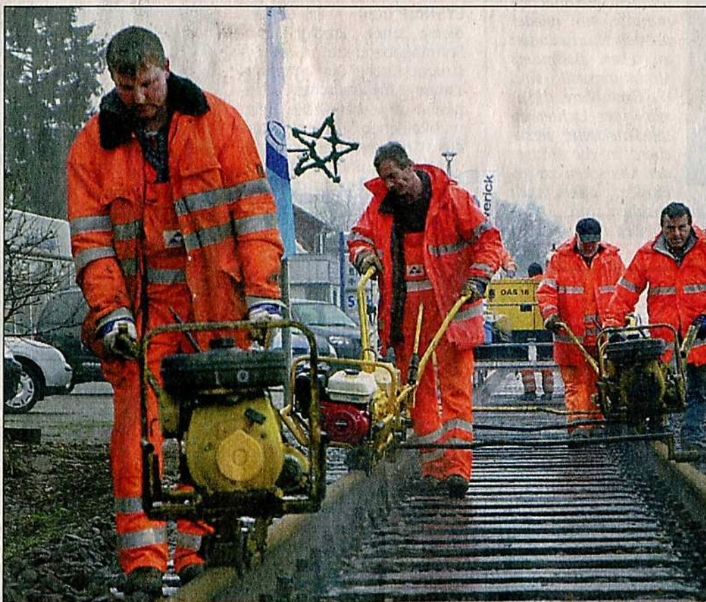
Buchstäblich letzten Schliff legen hier die Arbeiter an die „neuen alten“ Schienen: Der erste Abschnitt der Streckensanierung zwischen Heiligenfelde und Syke ist fertig. Nächstes Jahr wird weiter gebaut.
