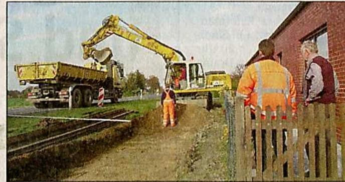
Ausgekoffertes Gleisbett für die neue Kleinbahn. Foto: hus
