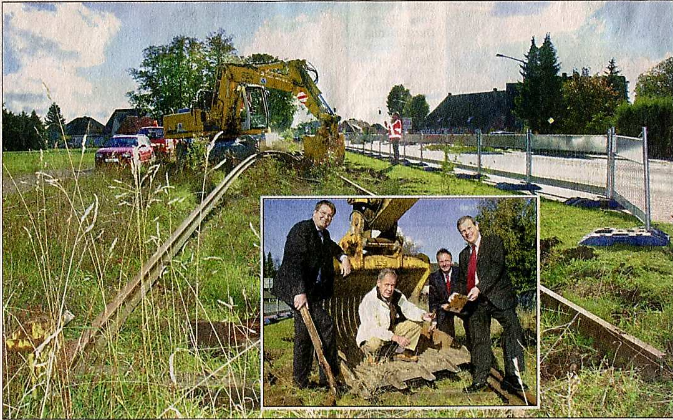
Stellenweise sind die alten Schwellen so morsch, dass der Bagger keine Mühe hat, die Schienen herauszureißen (großes Bild). Gestern erfolgte in Heiligenfelde der symbolische erste Spatenstich zur Streckensanierung (kleines Bild). Fotos (2): Husmann
