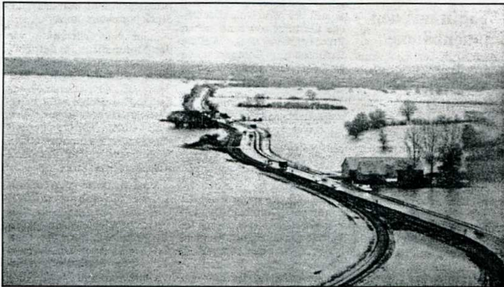
Hing die letzten Tage am „seidenen Faden“: Die Landesstraße zwischen Hoya und Hassel, die dem Hochwasser aber weiterhin trotzen wird und auch am Wochenende freibleiben soll.
