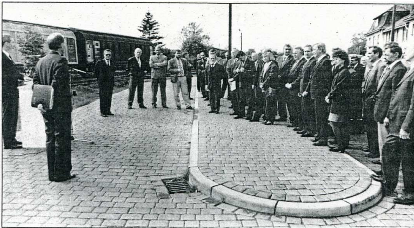
Zahlreiche Ehrengäste waren zur offiziellen Einweihung der sanierten VGH-Bahnstrecke zwischen Eystrup und Heiligenfelde zum Bahnhof nach Hoya gekommen. Betont wurde in den Ansprachen vor allem, daß es sich bei der Wiederherrichtung des Schienenstrangs um eine Investition der Zukunft handele.
